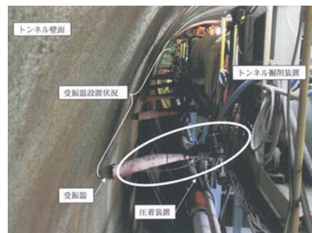
トンネル壁面に設置された受振器設置
