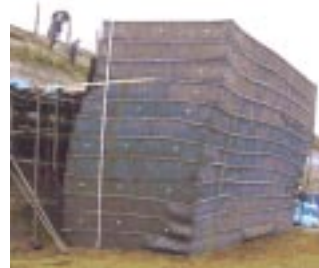
土堤式ジオロックウォール
