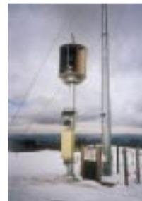
クロスフロー型風力発電装置
