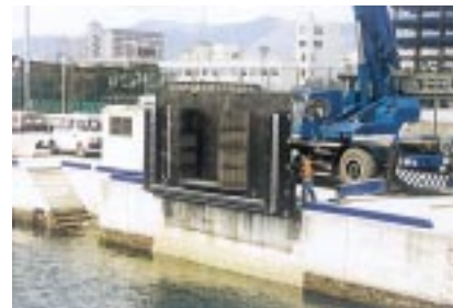
試作品の取付工事
