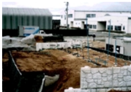
工法試験の現場
