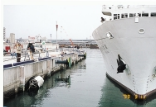
試作機の設置状況
