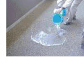
施工例:マンションのバリアフリー外廊下
