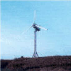
出力30kWティータ&フェザー機構付パッシブ制御水平軸風車
