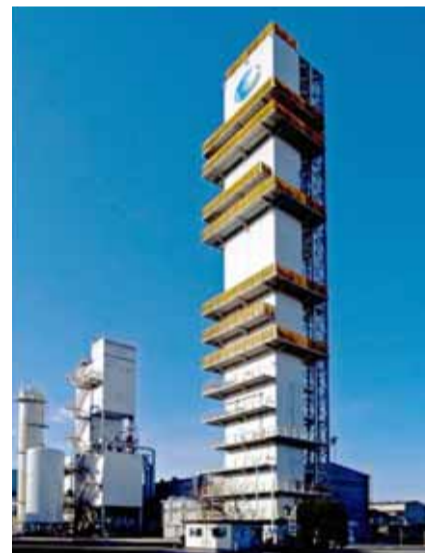
Water- 18 O製造プラント (約7m×3.5m×高さ70m)
