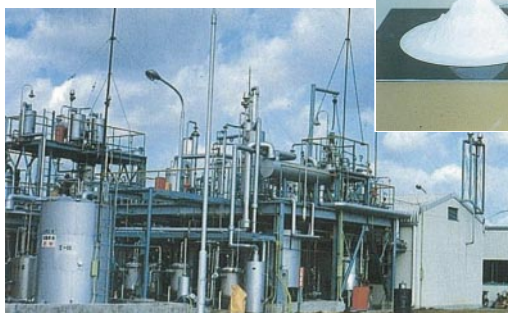
マルトール製造プラント
