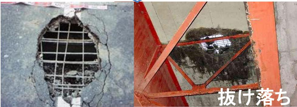
アスファルト舗装は防水性が不完全ながら供用後に不透水に近づく。しかし、舗装自体の劣化のため、やがて路面にひび割れ、ポットホールなどの損傷が生じる。
