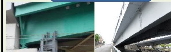
鉄道線路上鋼桁
