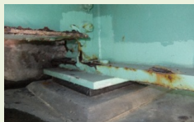
支承を含む桁端部
