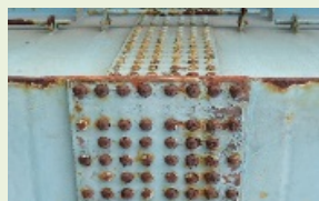
添接部・ボルト部
