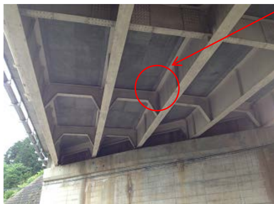
国道50号跨道橋
