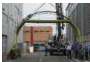
フレーム組立実証実験
