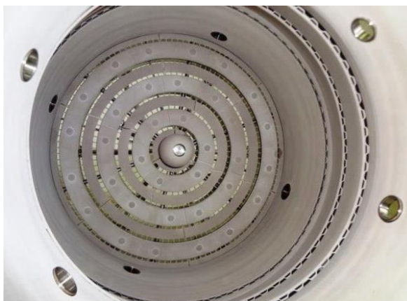
D) 燃焼器内部
