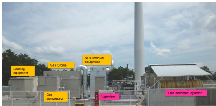
図 2 2. アンモニアガス供給方法 図 2 3. 常用のアンモニア供給設備 (1 トンボンベ)
