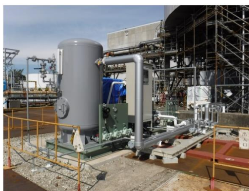
図 7 アンモニアガスコンプレッサ外観
