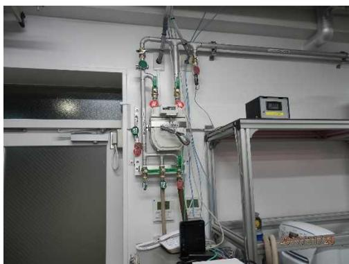
図 6 ヘリウム回収設備
