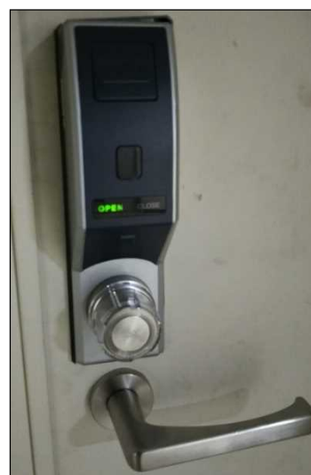
(図 2) 入退室認証・履歴記録装置
