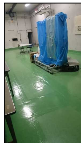
（図3）北実験棟7：床補修後
