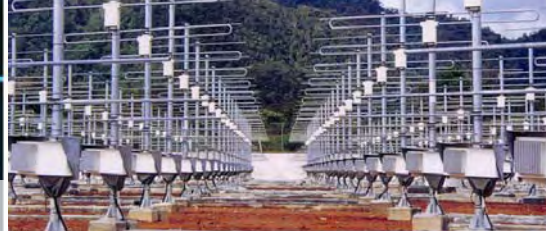
赤道大気レーダー(EAR): インドネシア・スマトラ島の赤道直下に位置する大型レーダーであり、2001年以来、長期連続観測を実施してきた。直径約110mの略円形アンテナ全景(上図) 八木アンテナ560本・送信出力100kW (左図)
