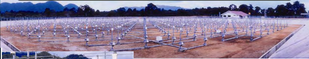
赤道大気レーダー(EAR): インドネシア・スマトラ島の赤道直下に位置する大型レーダーであり、2001年以来、長期連続観測を実施してきた。直径約110mの略円形アンテナ全景(上図) 八木アンテナ560本・送信出力100kW (左図)
