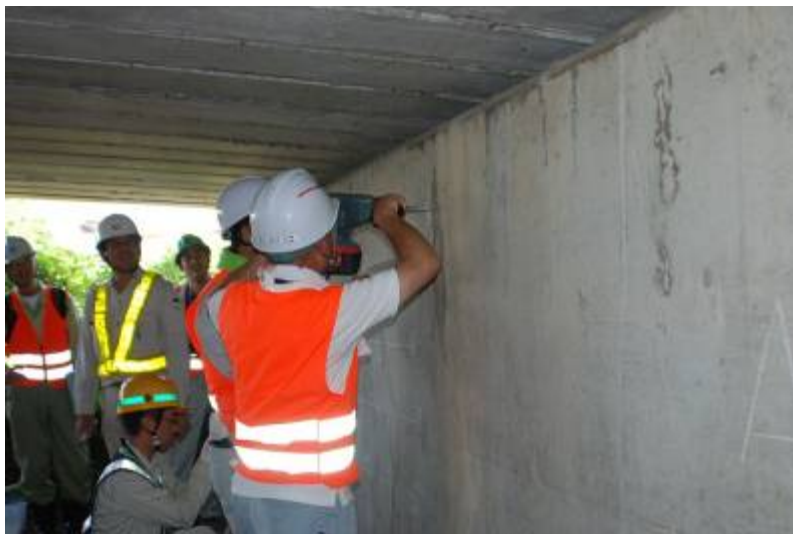
写真一3 橋梁に関するフィールド実習でコンクリートの中性化試験を実施する被養成者
