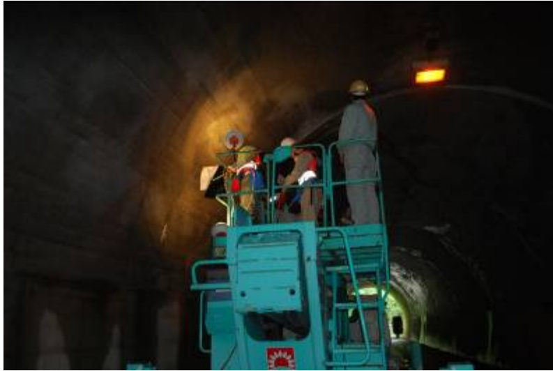
写真—4 トンネルに関するフィールド実習でトンネルの点検を実施する被養成者
