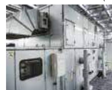
写真2. (a)燃料電池 (b)冷却装置 (c)低温排熱を利用した空調機
