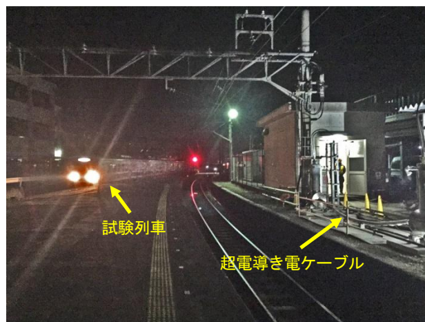
写真2 列車走行試験の様子
