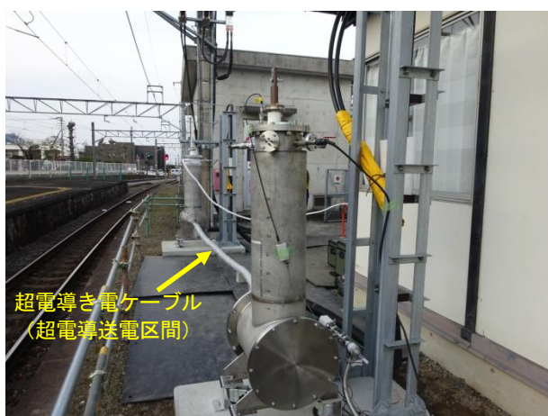
写真1 敷設した超電導き電ケーブル
