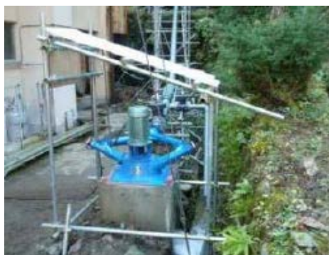
図 35 簡素化されている建て屋
