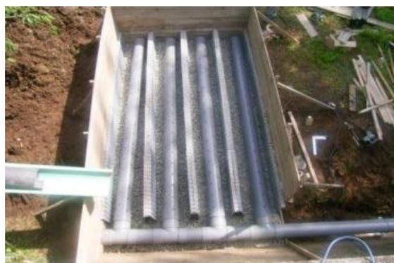
図 3-3-1-3 浸透取水装置の内部構造
