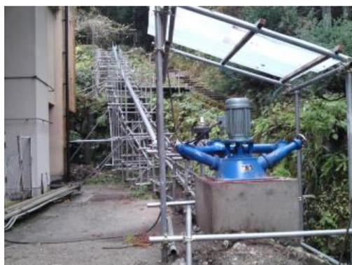
図 3-3-14-11 宇奈月温泉小水力発電所の起動式の様子とターゴインパルス型発電機
