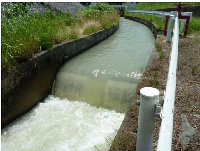
図 3-3-15-2 黒部川扇状地を等高線に直角方向に流れる農業用水路に設置されている落差工(落差: 1 m)
