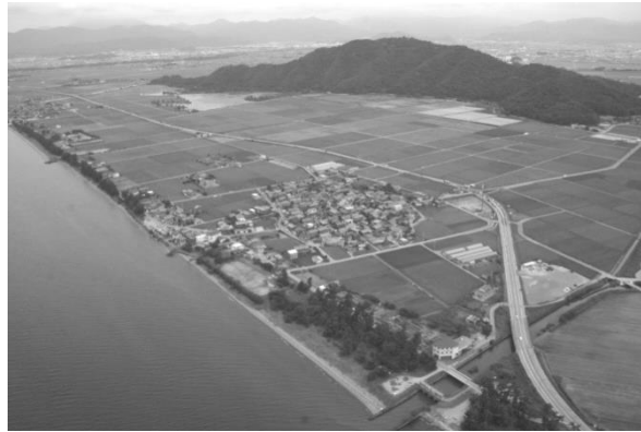
図 41 S集落俯瞰 撮影：奥貫隆(2006. 7. 12)
