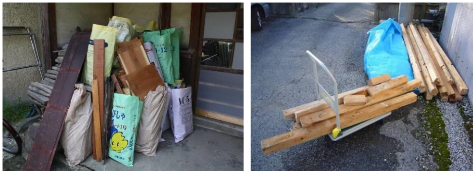
図 54 建物改修・建物解体時の廃材
