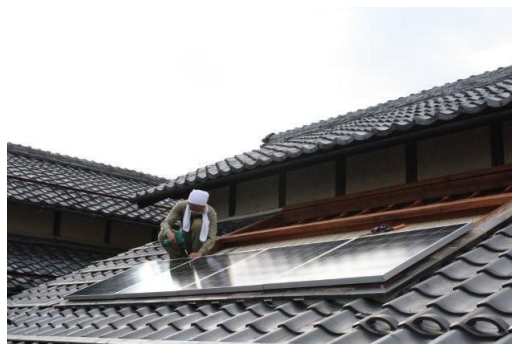
図 60 太陽光発電パネル設置の様子
