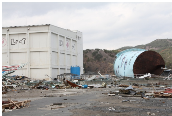
横転した石油タンク（1,000 キロリットル）
