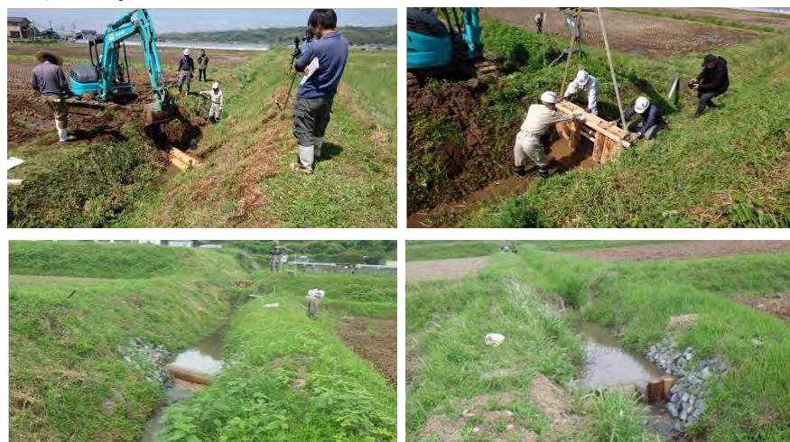
図2-11 施工された環境配慮型水路（上段：水路施工の様子、下段：施工された構造物）
