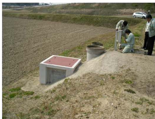
Fig.1 新設された流量計 (コンクリート枠の中)
