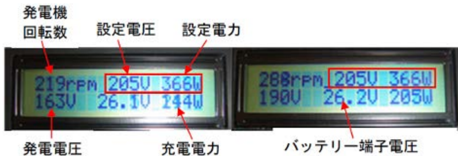
図4. 発電機特性 (充電用インバータ表示)
