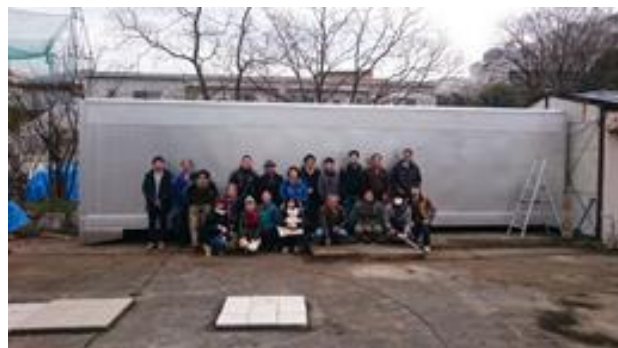
写真 19 建設中のあまみずセンター(中流)
