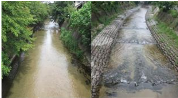
写真 14 戸井橋下流の河川改修前(左)と改修後(右)
