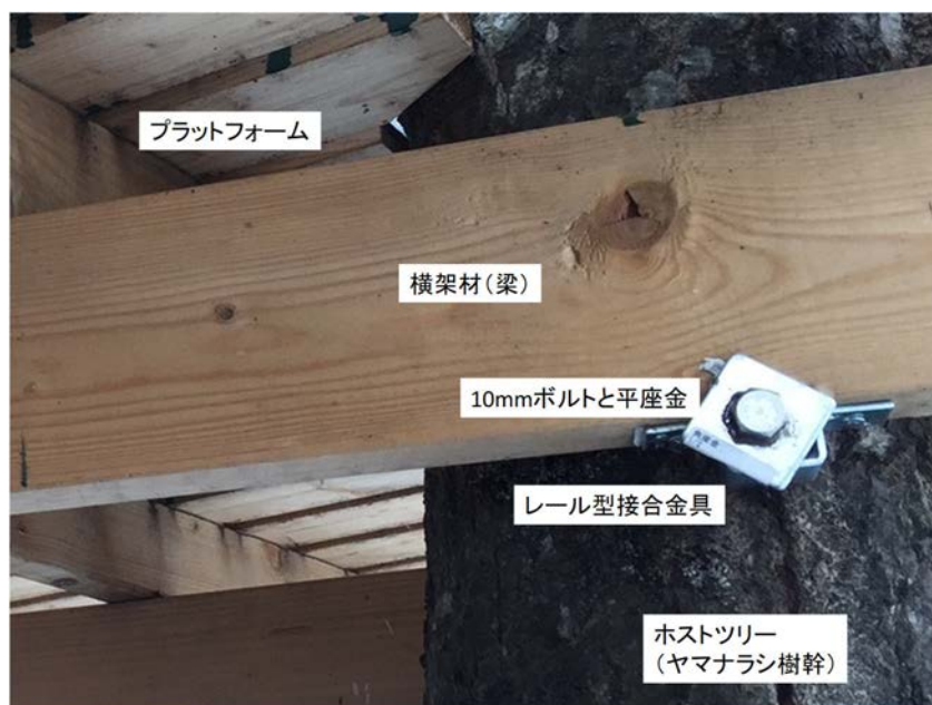
写真 8 ホストツリーとプラットフォームの接合
