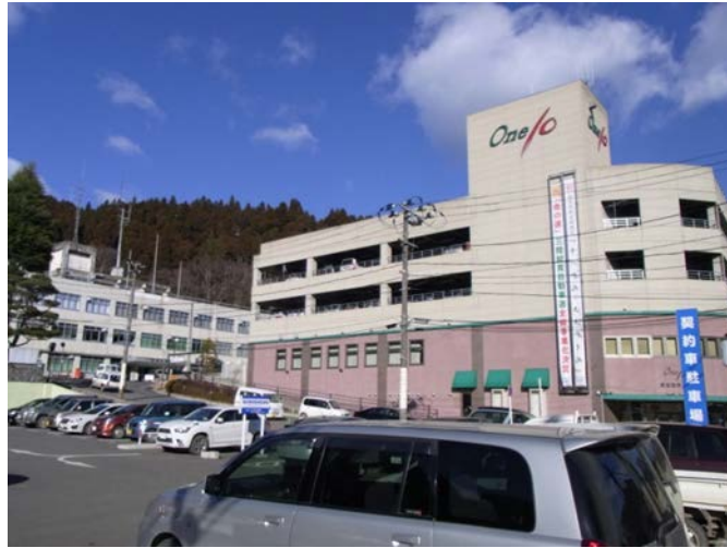
図1 対象自治体庁舎（気仙沼市役所）
