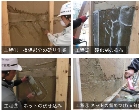
写真10 主要な補修工程
