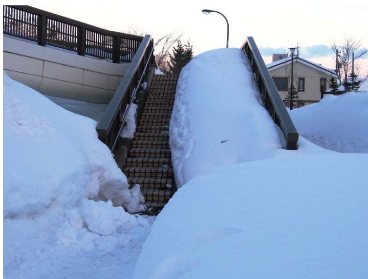
冬の札幌市北区拓北・あいの里 「雪に埋もれた歩道橋」 住民説明会当日（1月16日）の写真 地域の助け合いが必要とされる
