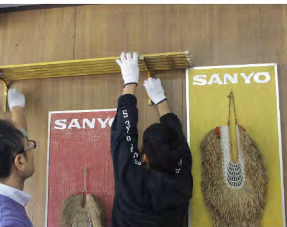
「繭細工工房「陽だまり」リノベーション」
