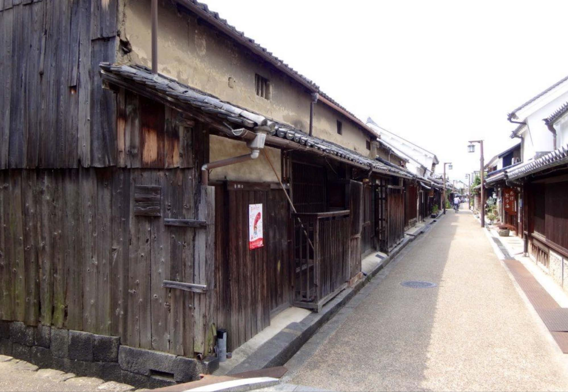
橿原市 学童保育施設( 修復前)
