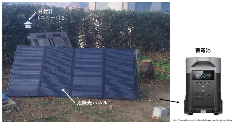
図A1-4 太陽光パネル・蓄電池、全天日射量計の設置状況
