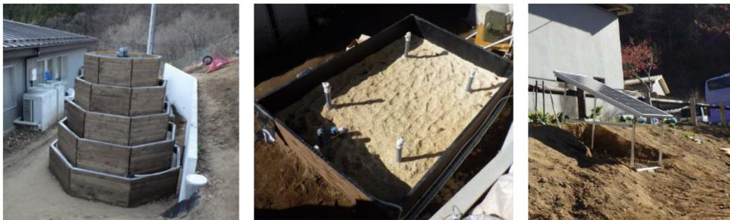
図B-3 大和自然学校に設置した人工湿地の1段目花壇式人工湿地（左）、2段目Tidal-flow人工湿地（中）、人工湿地の電源となる太陽光パネル（右）
