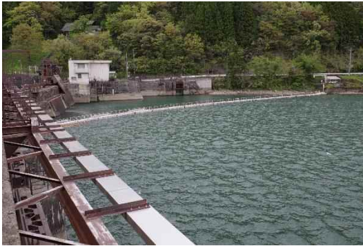
図4：神二ダムから農業用水への水の分配 図5：井田川水系土地改良区の縁を牛ヶ首用水が流下している。
