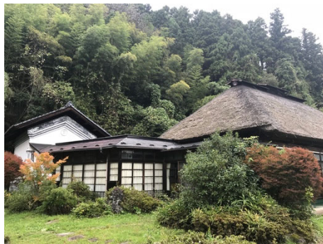
写真7 大崎市内のK家住宅(未活用) (2018.10.19)
