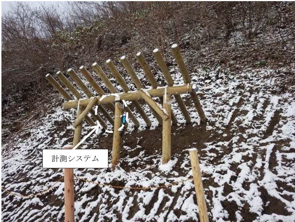
図-16 No.5地点 実証試験地システム敷設後状況
