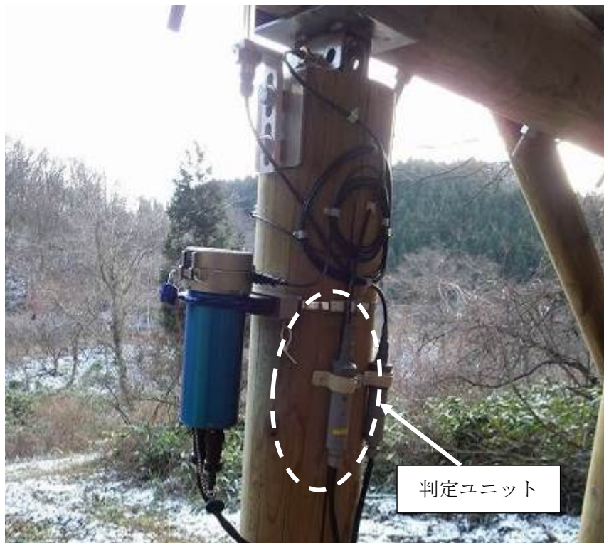
図-17 計測システム設置状況(判定ユニット)
