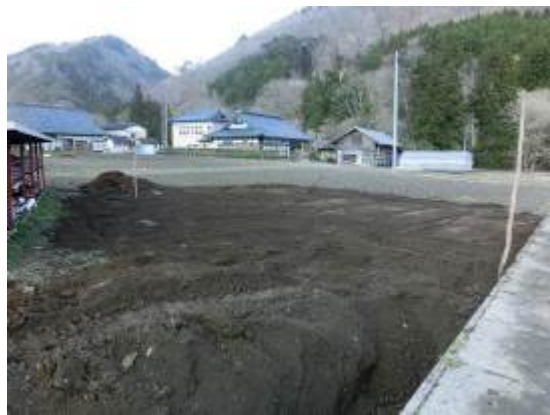
写真4：炭埋設後埋め戻した様子
