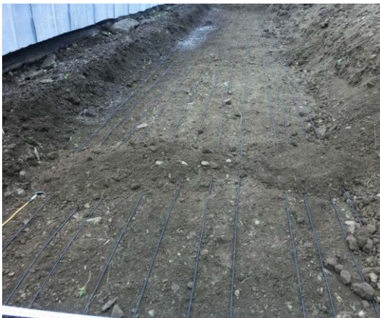
写真6：温床線埋設の様子
