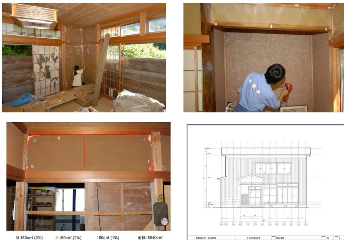
写真 10 被災状況の詳細調査と結果の図面化
