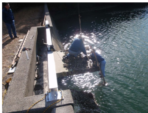
図2 水門開放工事の状況
