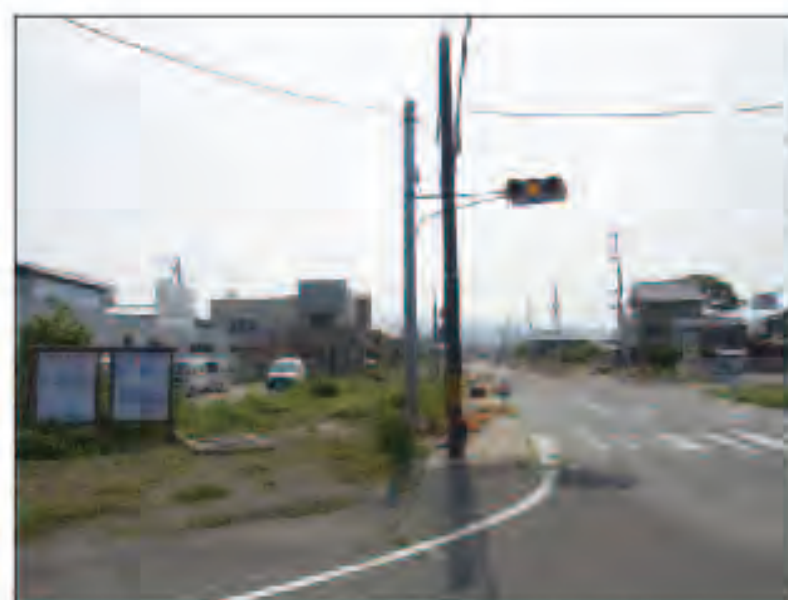
国道114号線の現状 ※ 2012/6/8 撮影
