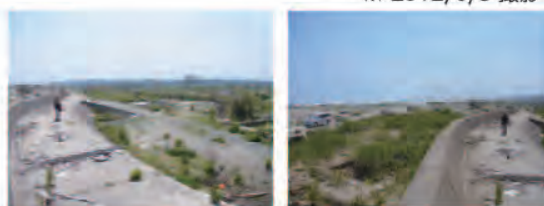
現在の防潮堤の様子
