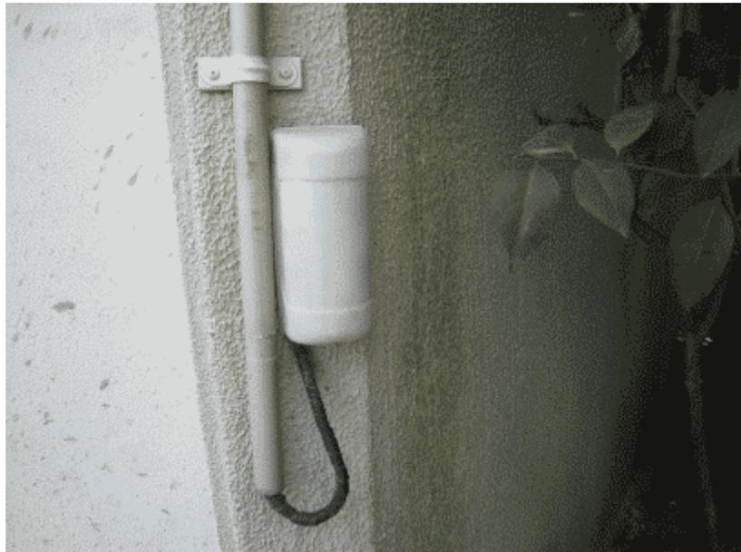
図 II-9 中門に設備されている人感センサ
