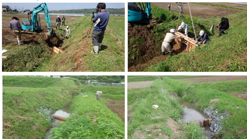
図 2-11 施工された環境配慮型水路（上段：水路施工の様子、下段：施工された構造物）
