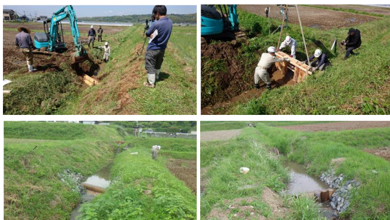
図3-3-2 施工された環境配慮型水路（上段：水路施工の様子、下段：施工された構造物）
