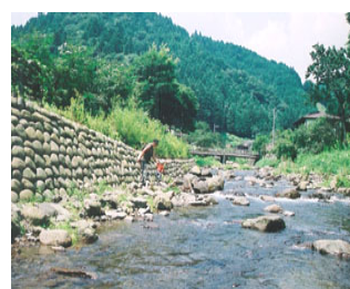
E アンカー式空石積工法
