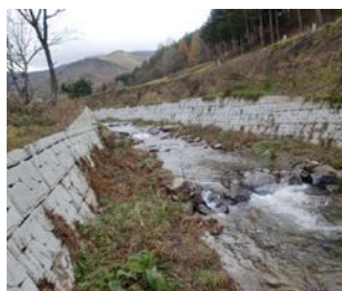
D コンクリート空積工法
