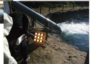
防水型発電機すいじん1号(最大3kW)による発電実験(落差2m強
